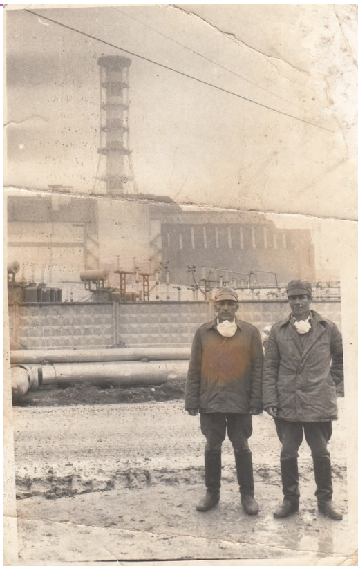
Чернобыль. Атомная станция 3 блок. За ней 4 блок, на котором и произошла ава-
